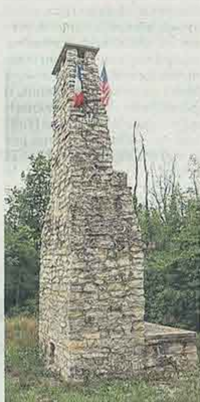
L'ancienne cheminée du foyer des officiers est visible depuis la RD 959. Photo F. S.
